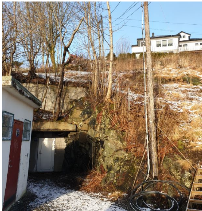
Figur 7-13. Bilde av inngangen til HB125 (rett fram) med pumpehuset til venstre (Foto: SINTEF).
