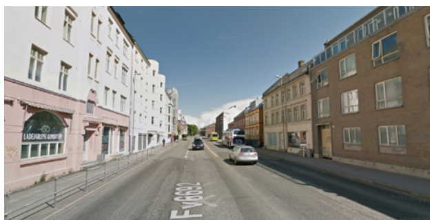
2014: Innherredsveien med tofelts kjøreveg Foto: Google street view
