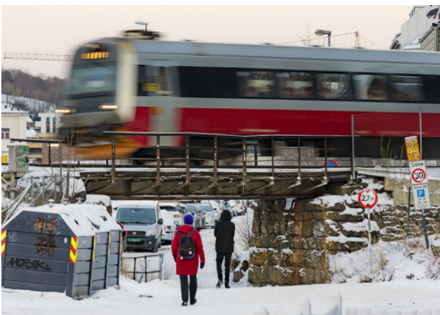
Undergang jernbanen ved Svartlamon
